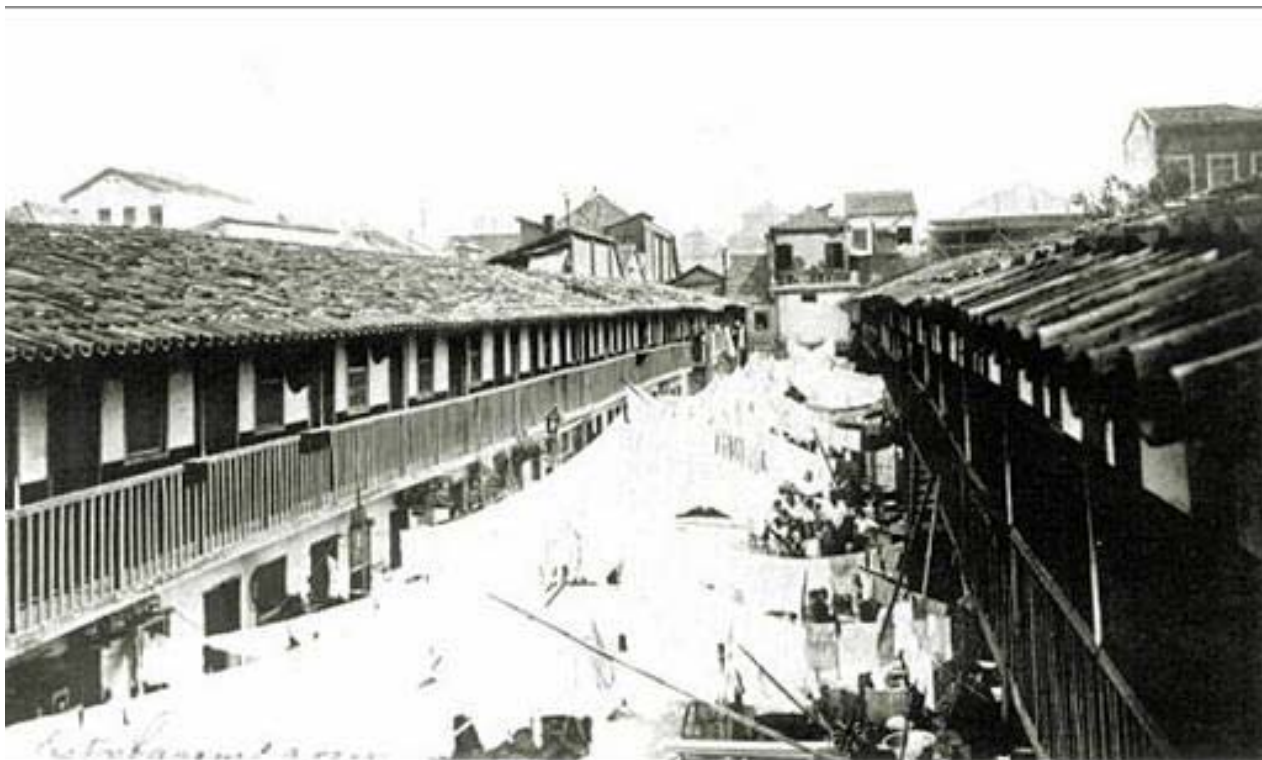
Cortiço na Rua dos Inválidos, no Rio de Janeiro (1890). Totalmente insalubre.
